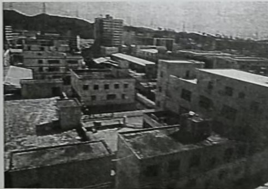
项目西侧厂房
