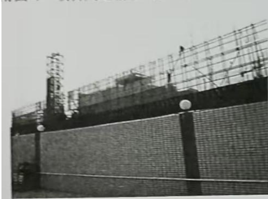
项目北侧在建厂房
